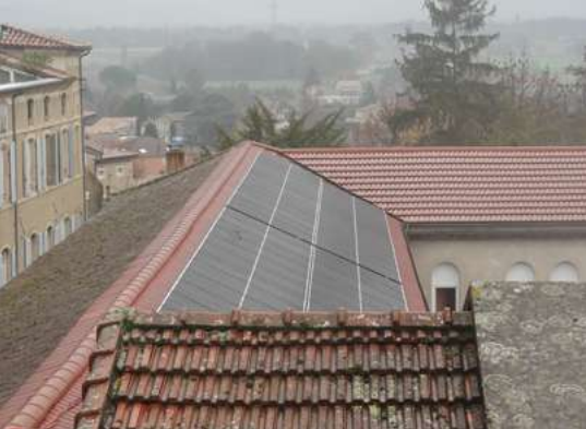
Panneaux solaires à la Maison St Joseph
